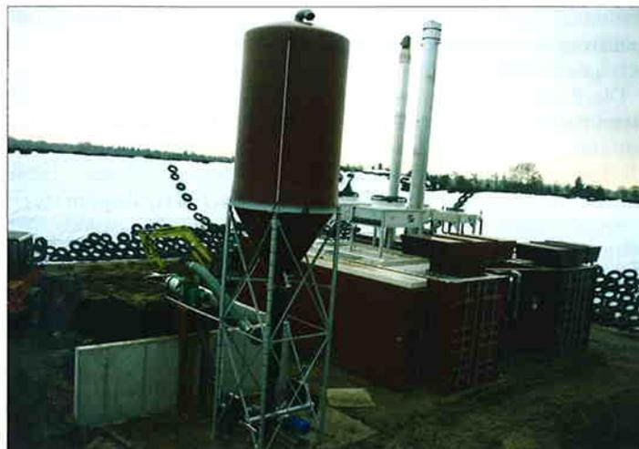
Mit einem Separator (grünes Gerät, Bildmitte) lassen sich flüssige und feste Stoffe trennen, wobei die Flüssigkeit im Prozess zur Verflüssigung von Energiepflanzen zurückgeführt werden kann.
